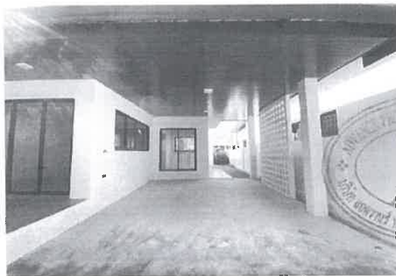
สภาพส่วนโค้งหลังคาคลุม (จอดรถ)
