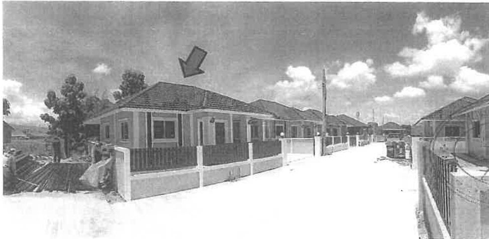
สภาพด้านหน้าทรัพย์สินที่ดิน - อาคารหลักประกัน
