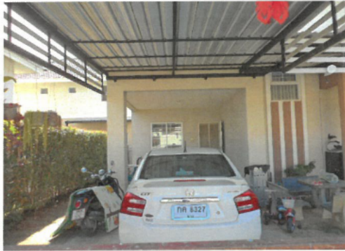
สภาพภายในอาคารหลักประกัน ชั้นล่าง / ส่วนโถงหลังคาคลุม
