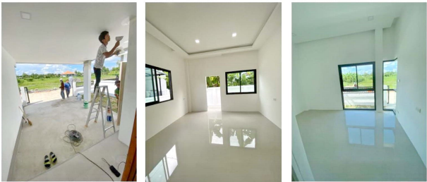
สภาพภายในอาคารหลักประกัน / ส่วนโถงหลังคาคลุม , ห้องโถง และ ห้องนอน
