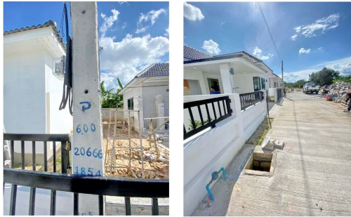
สภาพเสาไฟฟ้าผ่านหน้าหลักประกัน /สภาพท่อระบายน้ำผ่านหน้าหลักประกัน
