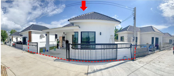
สภาพภายนอกอาคารหลักประกันบ้านเดี่ยว 1 ชั้น ไม่ติดเลขที่
