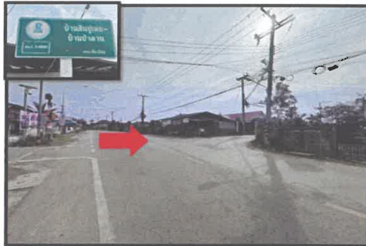
ถนนสายคดเคี้ยวสะเท็ด - บ่อสร้าง (ทล.1014) บริเวณแยกเข้าถนนบ้านสันป่าเลอ - บ้านป่าลาน (ชน.ด.1-0091) ( จุดถ่ายภาพที่ 1 )
