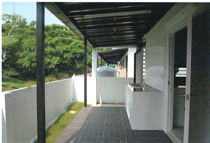
สภาพภายในอาคารหลักประกัน ( ส่วนโถง ชักล้าง )
